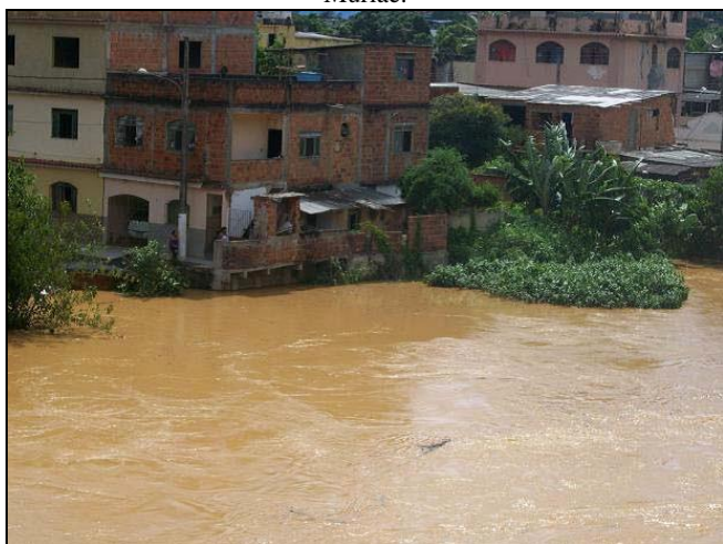
Figuras 1 e 2 – Efeitos das inundações do rio Muriaé em Laje do Muriaé.
